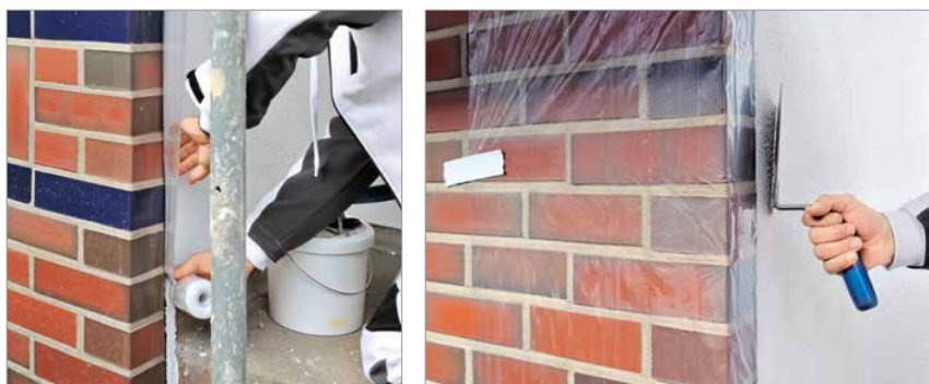
Maskiranje nepristupačnih područja bez poteškoća: tesa za jednostavno pokrivanje® 4373 i posebnu zaštitu od UV zračenja.
