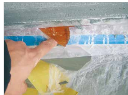
Drvo oštećeno nepravilnim maskiranjem prilikom žbukanja. Pravilan odabir u ovom slučaju bila bi traka tesa® 4363 ili rješenje 2-u-1, tesa za jednostavno pokrivanje® 4373 i posebnu zaštitu od UV zračenja.
