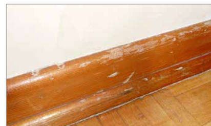
Lijevo i gore: oštećenje starijih slojeva laka/boje zbog maskirnih traka s jakom početnom snagom lijepljenja
