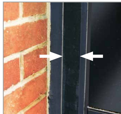
Tamne mrlje od trake na oštećenim površinama od anodiranog aluminija, bez ostataka smjese ljepila
