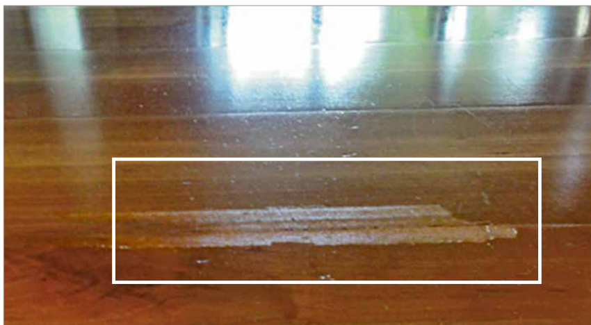
Odljepljivanje laka na gotovim drvenim podovima obrađenim UV-lampama kao posljedica primjene maskirne trake s prekomjernom snagom lijepljenja
