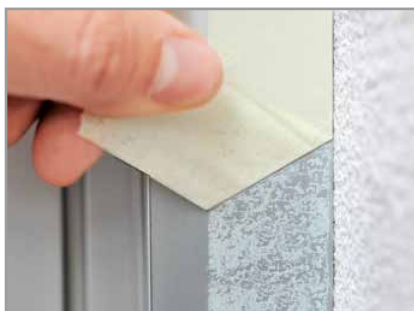
Ostaci smjese ljepila na anodiranom aluminiju
