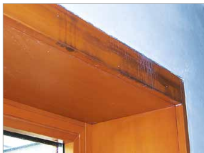
lako je dovratnik vrata maskiran gotovo zrakonepropusno, voda je prodrla iza trake i sušenje nije bilo moguće.
