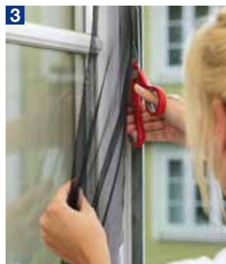
3 Jednostavno odrežite višak trake
