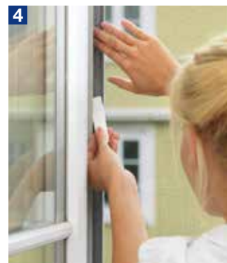
4 Koristite pritisnu četku radi savršenog prijanjanja
