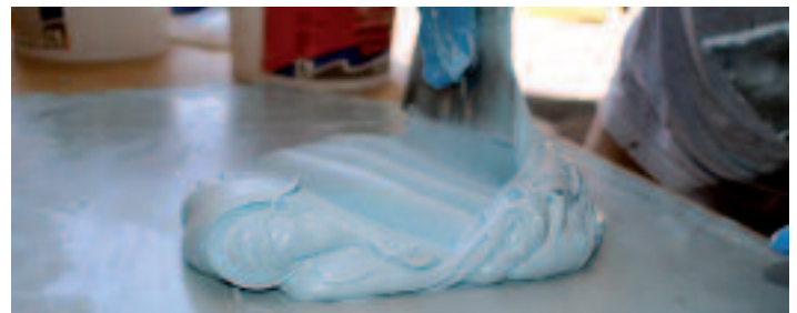
Obje komponente kita Epomast pro moraju biti promiješane dok ne dobiju ujednačenu boju.
