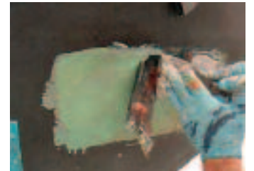
Ako pravilno koristite AQUASTRIP moguće je skinuti više slojeva boje sa običnom lopaticom.
