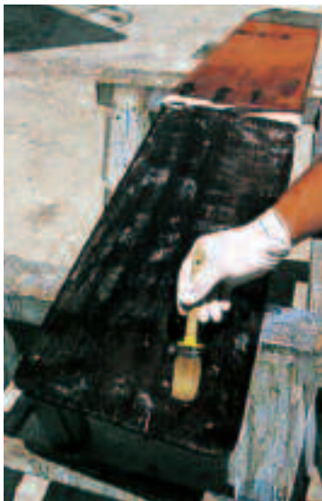
Premazivanje jednog sloja Fibrodur-a.
