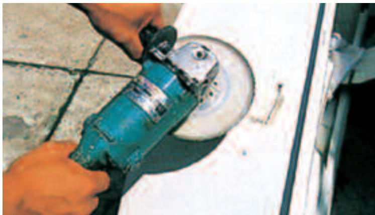
Brušenje brusnim diskovima je najefikasnija priprema za nanašanje Resina 2000.
