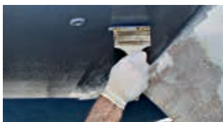
Kistom razvucite Hempel's High Protect u suprotnom pravcu
