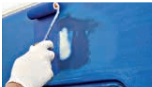
Mjestimično nanošenje temeljnog premaza
