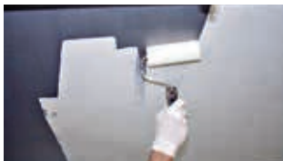
Nanesite antifauling povrh temelja ili izolacijskog premaza
